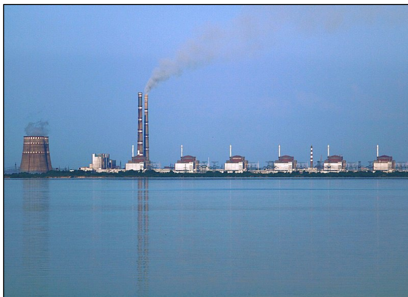
Figur 2.1 Zaporizjzja kjernekraftverk. (Fra Wikimedia Commons, lastet opp av brukeren Rehman. CC-BY-SA-3.0,2.5,2.0,1.0. https://commons.wikimedia.org/w/index.php?title=File:Kernkraftwerk_Saporisc_hschja_retouched-1.JPG&action=edit&redlink=1 )
